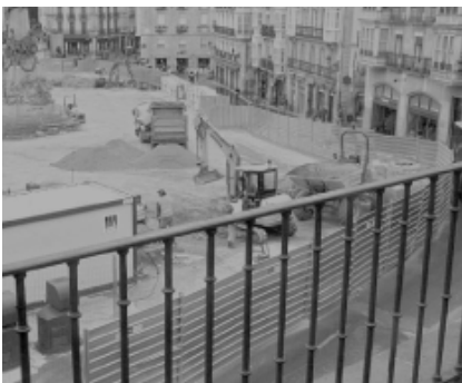
Obras de la Virgen Blanca vistas desde la balconada.
