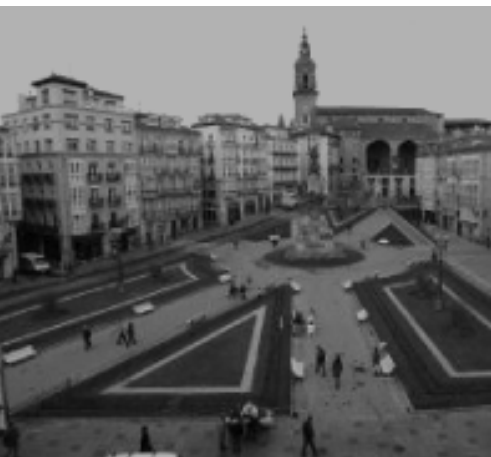
Plaza de la Virgen Blanca antes de la remodelación.
